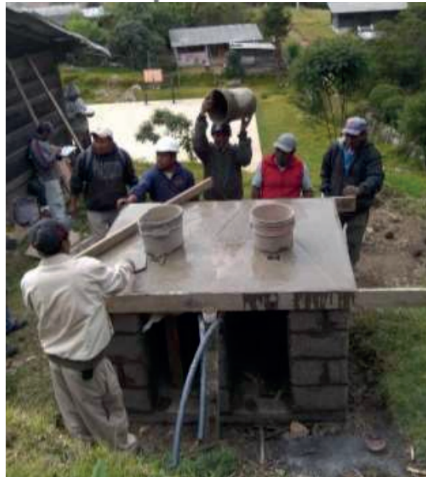
Figura 18. Colado de la losa de concreto
