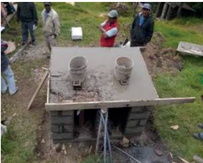
Figura 18. Colado de la losa de concreto
