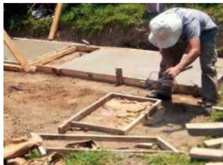
Figura 5. Armado de la cimbra para la construcción de tapas de las cámaras del baño
