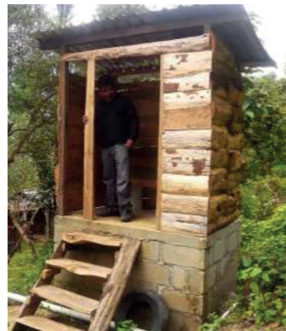
Figura 19. La caseta del baño seco se construye con materiales de región
