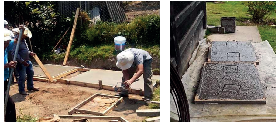
Figura 10. Colocación de las asas de las tapas
