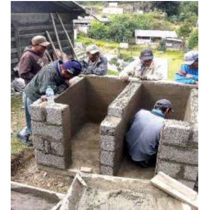
Figura 13. Aplanado de muros interiores
