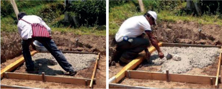
Figura 8. Colado de la losa de cimentación
