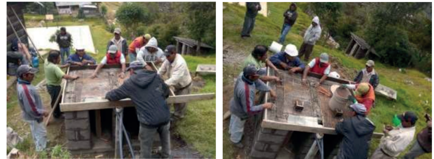
Figura 17. Preparación de espacio para la taza con un bote plástico de 19lts y caja de madera de 15 x 10cm
