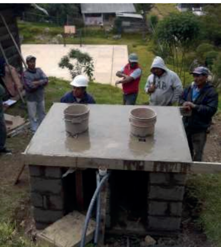
Figura 19. La caseta del baño seco se construye con materiales de región
