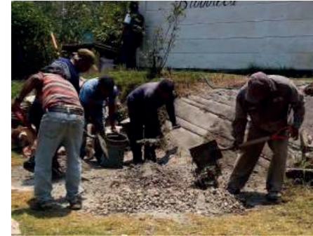
Figura 6. Mezcla para la losa de cimentación del baño
