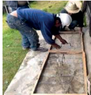
Figura 9. Colado de la losa de cimentación
